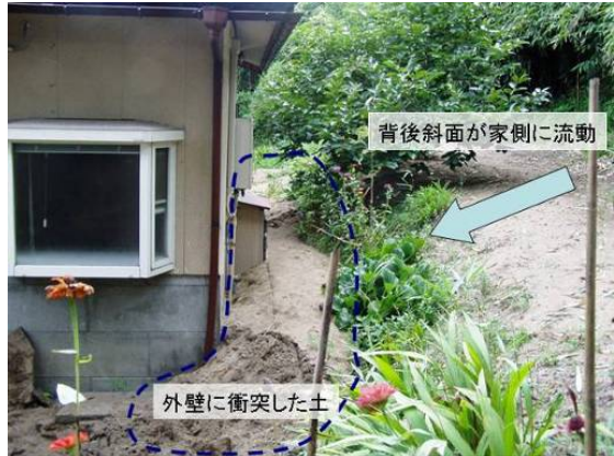
写真 3.2.12 砂丘斜面の流動による 家屋被害 1
