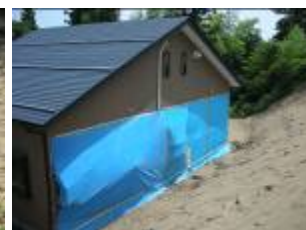
写真 3.2.4 表層崩壊による建物被害
