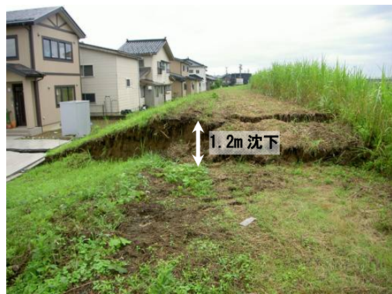
写真 3. 2. 48 鯖石川新河道堤防の沈下 （柏崎地域振興局提供）
