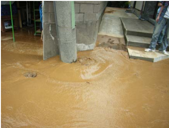
写真 3.2.69 写真 3.2.68 と同じ地点の 最大余震 15 分後 (15:29) 電柱周りの噴砂 (撮影地点⑮)
