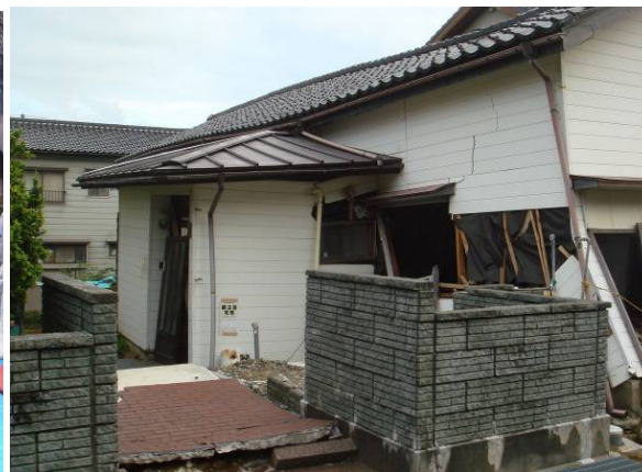
写真 3.2.99 下段側 (写真奥) へ大きく 傾いた中段の家屋
