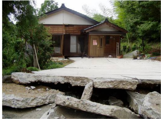
写真 3.2.10 宅地の沈下・流動による 家屋被害 2
