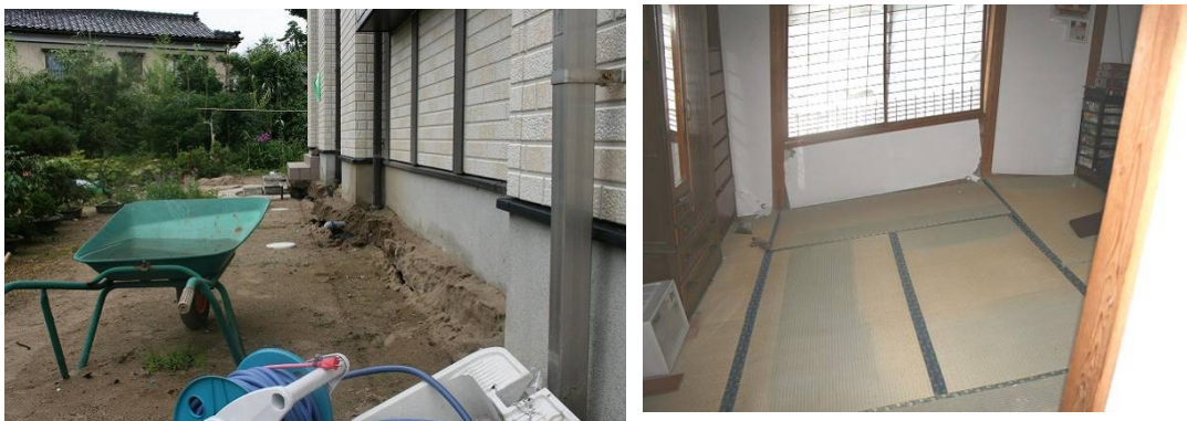
写真 3.2.28 杭支持家屋の前庭の沈下 (No. 15)
