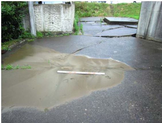
写真 3. 2. 45 道路上に残る噴砂（旧河道以外）
