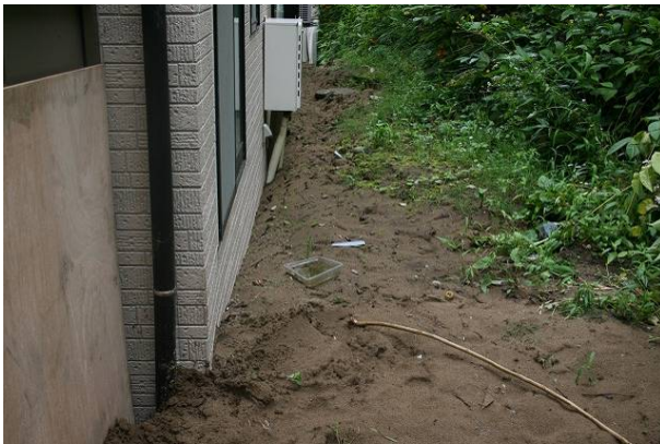
写真 3.2.24 斜面崩壊土砂の直撃 (No. 10)
