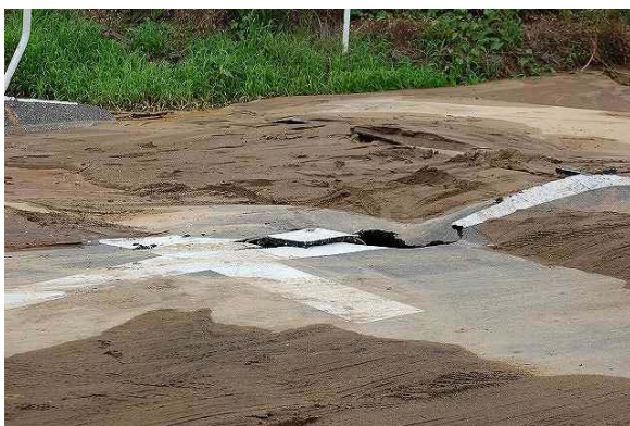
写真 3. 2. 59 道路上の噴砂 (本震 4 時間後) (撮影地点⑦) (Te 氏撮影)
