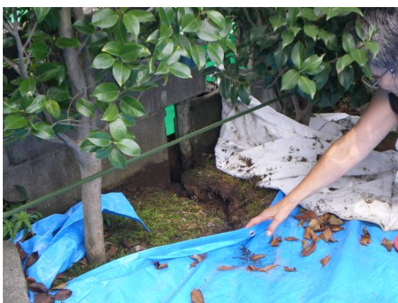
写真 3.2.98 敷地を跨いで生じている亀裂 (北側地域中段の敷地) (北側地域の上・中段間道路より撮影)
