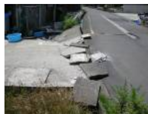
写真 3.2.5 砂丘地割れ・側溝狭窄
