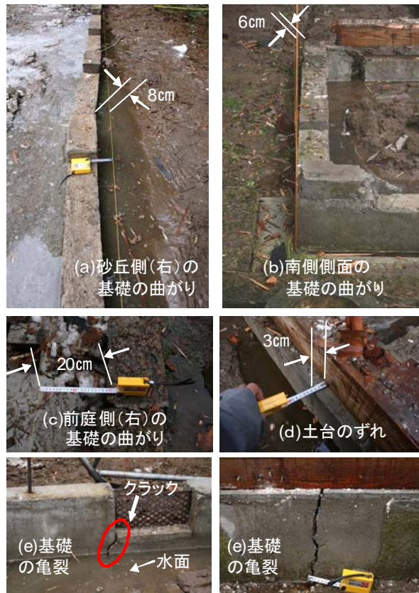
写真 3.2.20 基礎の被害状況 (No. 4)
