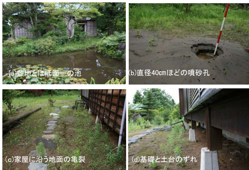
写真 3. 2. 21 低湿地の液状化関連被害 (No. 7)
