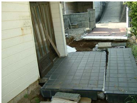
写真3. 2. 102 宅地内に生じた段差 (図3. 2. 84のPhoto(B)) (写真3. 2. 99の家屋の別アングル)
