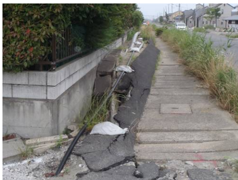
写真 3. 2. 127 ライフラインの浮き上がり現象
