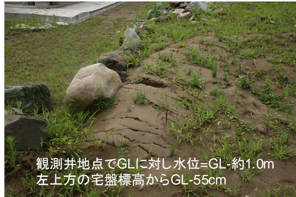
写真 3. 2. 34 斜面法尻の地盤の隆起 (No. 18)
