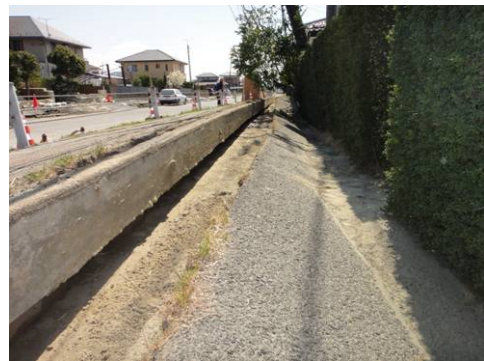
写真 3. 2. 126 道路側溝の隆起現象
