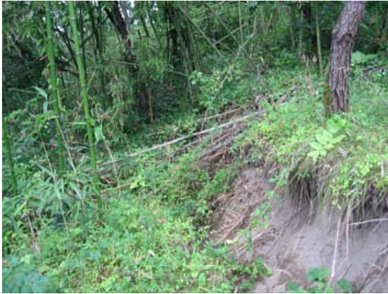
写真 3.2.15 亀裂部分で緊張した根茎
