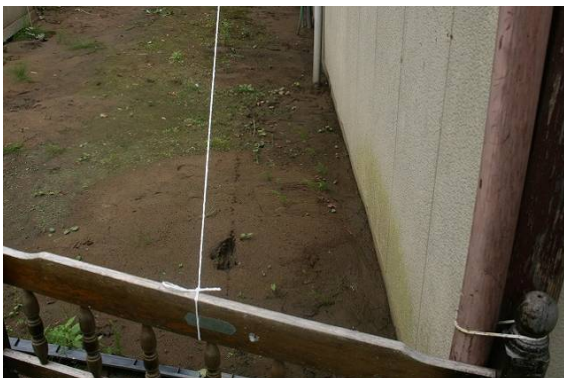
写真 3.2.32 宅地内の噴砂痕 (No. 16)
