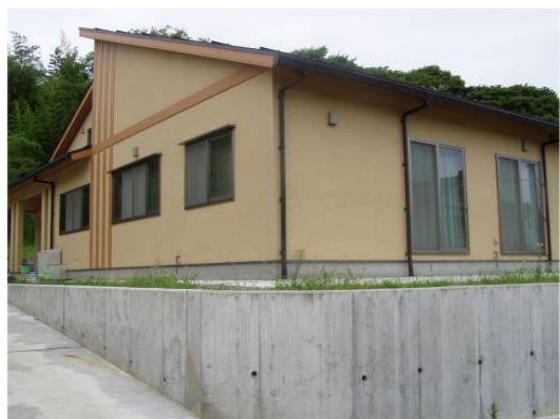
写真 3.2.14 被害が軽微であった家屋
