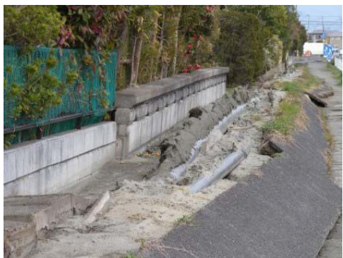
写真 3. 2. 127 ライフラインの浮き上がり現象
