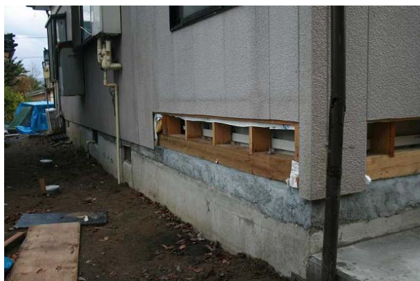
写真 3. 2. 33 噴砂痕は無いが不同沈下 (No. 17)
