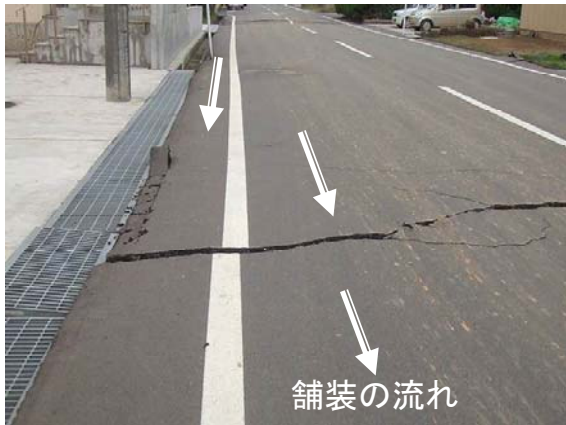
写真 3. 2. 58 噴砂・噴水が無い町内西半分。 地盤の変形による舗装の亀裂。 (本震 40 分後) (撮影地点⑥)
