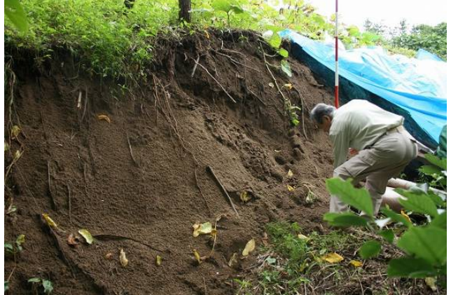
写真 3.2.16 斜面中腹に見られた滑落崖
