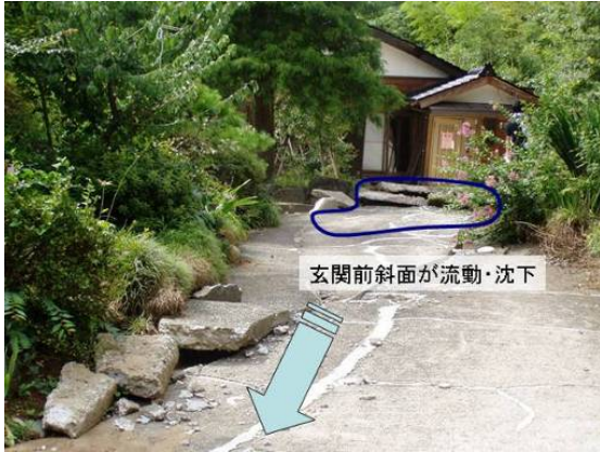
写真 3.2.9 宅地の沈下・流動による 家屋被害 1
