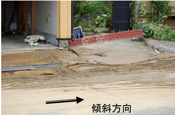
写真 3.2.63 地盤傾斜方向への舗装の流れ (本震 4 時間後) (撮影地点⑩)
