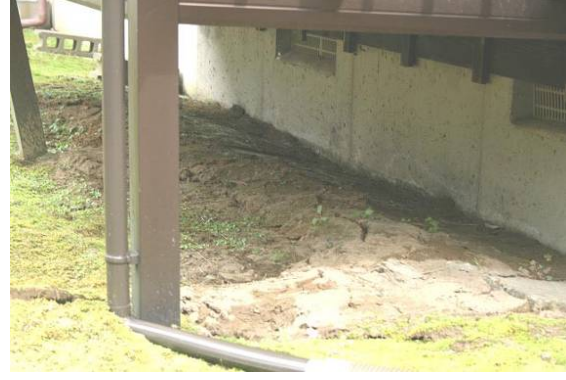
写真 3. 2. 41 建物背面の地盤の隆起 (No. X)
