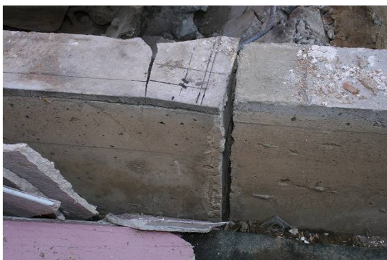
写真 3. 2. 76 打ち継ぎ目に鉄筋無し（家屋 e） 写真 3. 2. 77 基礎のコーナーにも鉄筋無し
