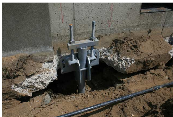
写真 3. 2. 79 傾いた家屋 17 のジャッキアップ
