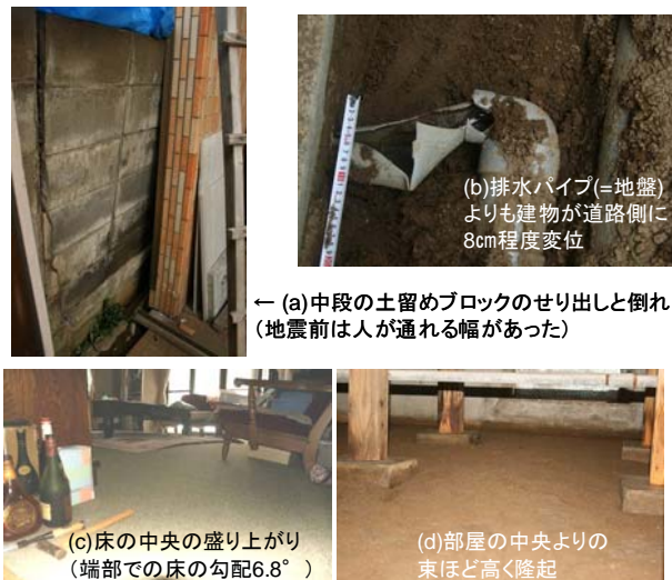
写真 3.2.113 擁壁の衝突と建物の変位 (m 宅)
