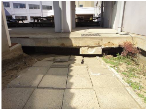
写真 3. 2. 124 建物の基礎地盤の沈下
