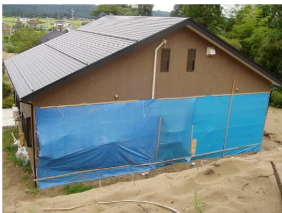
写真 3.2.13 砂丘斜面の流動による 家屋被害 2
