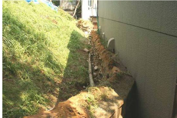
写真 3.2.104 a 宅の背面に衝突した擁壁
