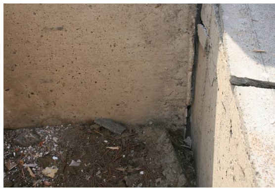
写真 3. 2. 76 打ち継ぎ目に鉄筋無し（家屋 e） 写真 3. 2. 77 基礎のコーナーにも鉄筋無し
