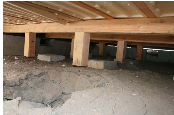
写真 3.2.23 増築部の束と束石のずれ(No. 8)
