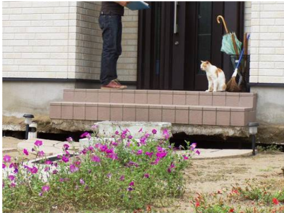
写真 3.2.11 宅地の沈下・流動による 家屋被害 3
