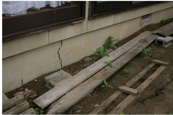
写真 3.2.31 基礎の亀裂 (No. 16)
