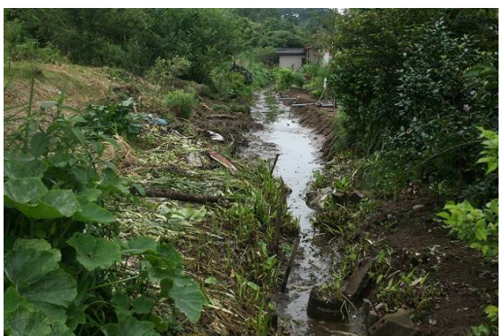
写真 3.2.111 閉塞後に開削された i 宅裏の水路
