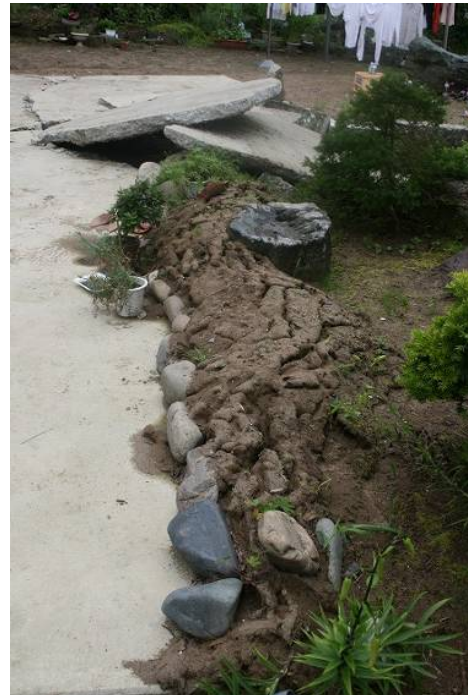
写真 3.2.25 前庭（道路側）の隆起 (No. 10)
