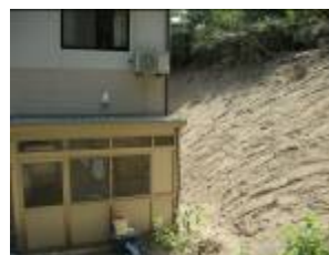
写真 3.2.4 表層崩壊による建物被害
