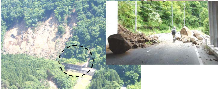
崩落(落石)に耐えたスノーシェッドの例
