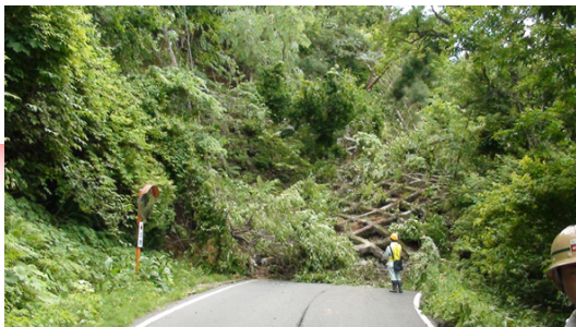
フリーフレームの倒壊事例
