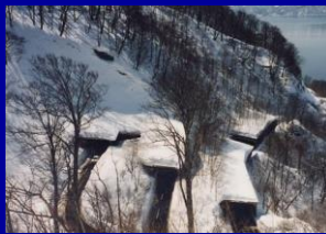
青森県 国道102号 スノーシェッド
