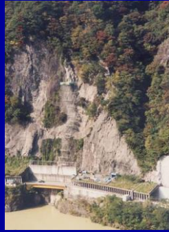
国道156号上方斜面
