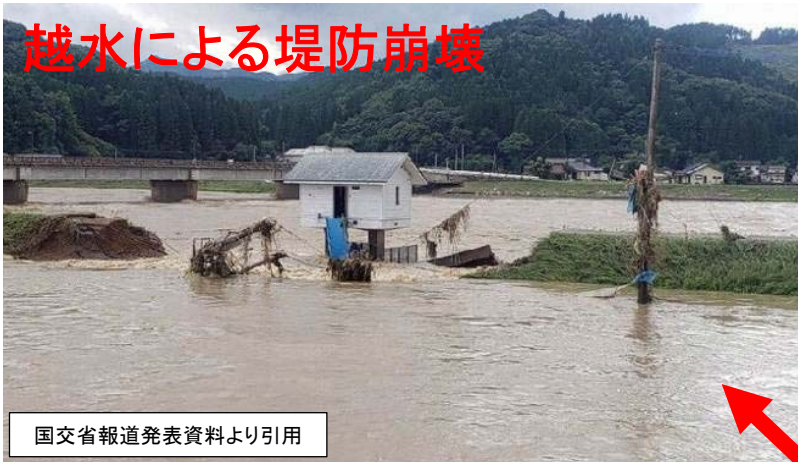
越水による堤防崩壊
