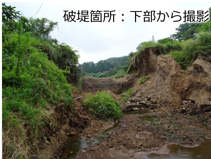
大分県杵築市中ノ池堤体の崩壊
