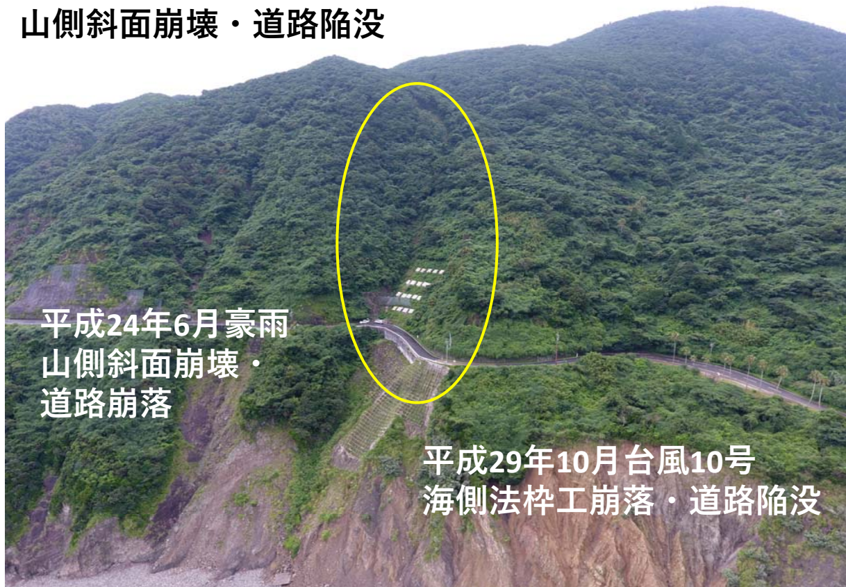
繰り返し変状する対策斜面（R448宮崎・串間市）
