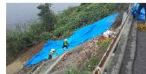
▲法面清掃状況
