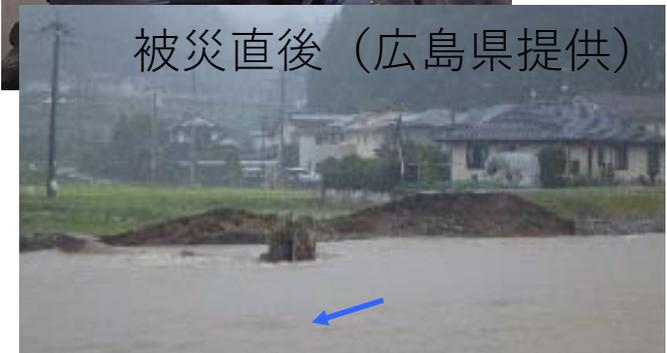
越流開始直前に水面が激しく波立っており，河道内において構造物が破壊したなどが考えられる．水面が上昇した流れによって堤防のアスファルトがめくれ上がり，越流が始まった．
