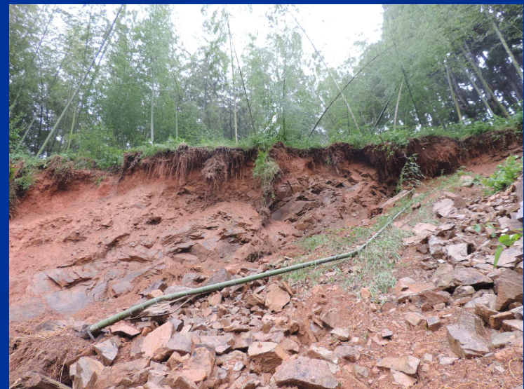
頭部の多亀裂性風化砂質片岩層から大量の岩塊が供給されている
