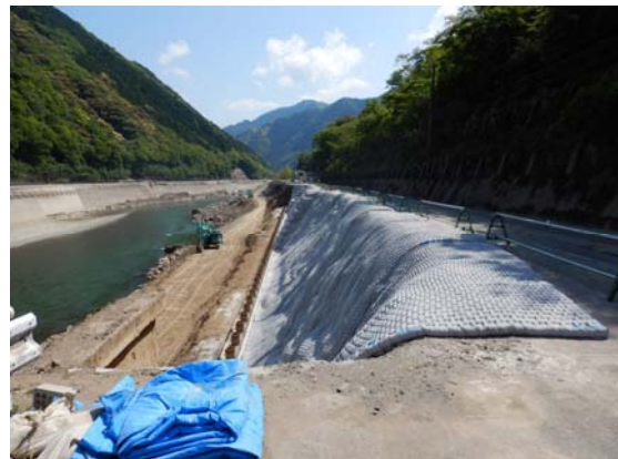
写真-15 災害③の復旧状況
