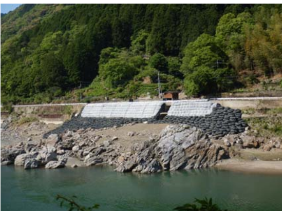
写真-16 被災⑤の復旧状況
