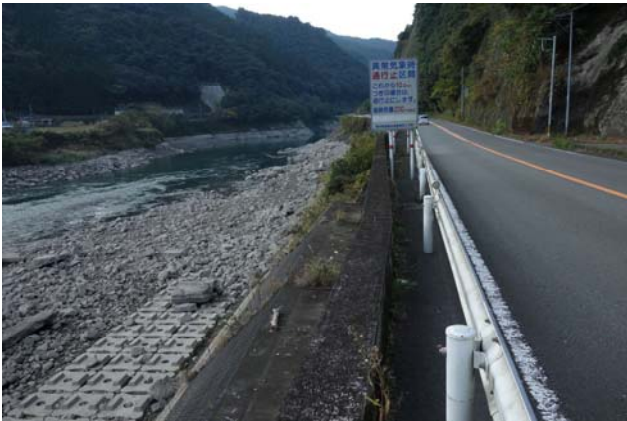
写真-3 豪雨前の国道219号 （一部異常気象時通行止め区間あり）
