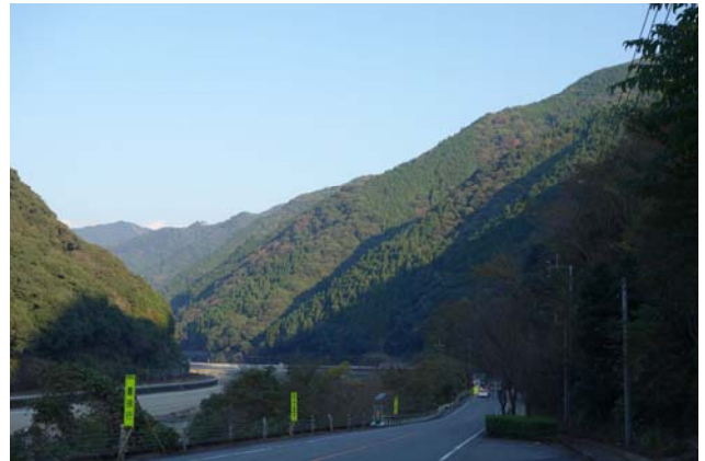
写真-4 豪雨前の国道219号 （非常に急峻な山地の谷間を通る）
