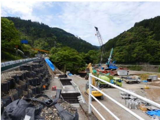
写真-14 被災②の復旧状況
