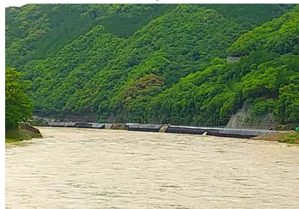
写真-17 災害⑦の復旧状況
