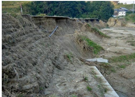
写真4.6.2 越流による堤体の侵食 ● 2004年豪雨災害でのため池の被災 ● 土質選定と締固度の適切な管理による高耐久化の可能性
