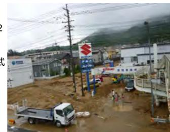
土石流の出口の前の橋梁工事現場。掘削箇所に3000m3程度の土砂が堆積したと推定される。
