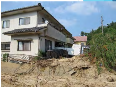
土石流に流されたトラックが住宅に突っ込む
