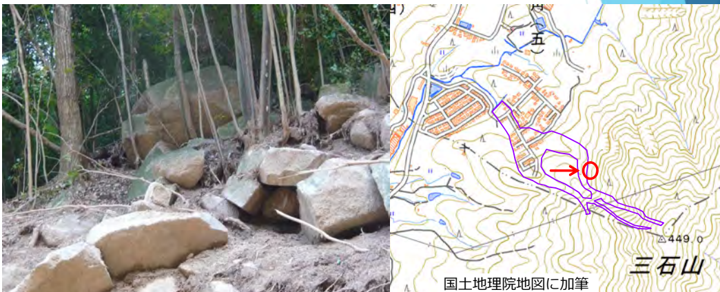
溪流の側面斜面には過去に崩落した巨石が多数あり
