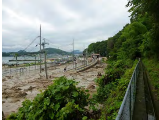
土砂が流入したJR呉線の水尻駅（7月8日午後撮影）
