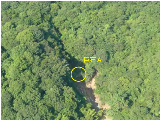
土石流溪流の左岸側面に存在する巨石A（7月10日撮影） 11m×5m×5m程度のコアストーン
